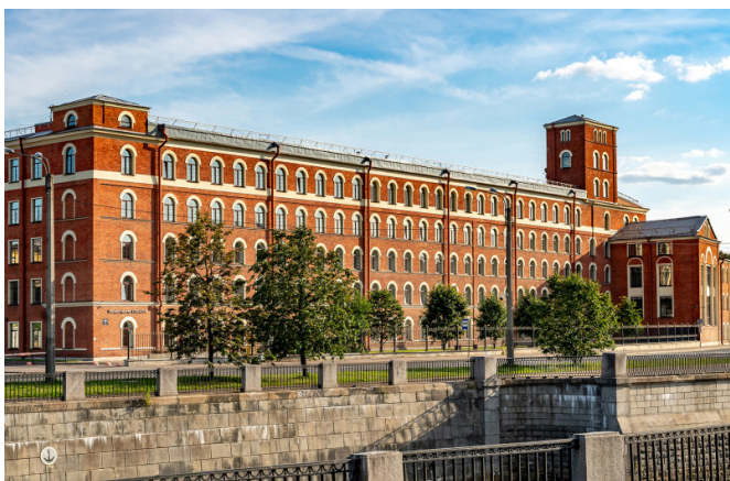
Наб. Обводного канала, д. 60
